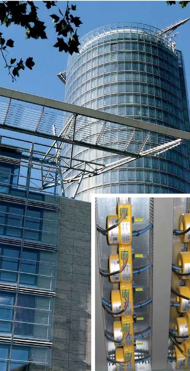
Um die beiden Projekte auf ein gemeinsames Konzept hin auszulegen, wurde auch im Hinblick auf eines der beiden im Neubau untergebrachten Rechenzentren eine Differenzstrom-Überwachung installiert. Durch deren gezielten Einsatz können Abschaltungen während des Betriebes durch wiederkehrende Prüfung der Systeme (z. B. bei Isolationsmessungen) weitestgehend vermieden werden.
